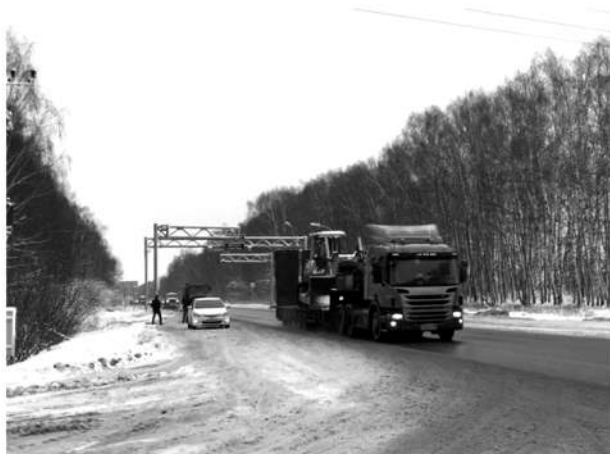
Рис. 19. АПВГК, на региональных дорогах Нижегородской области, оснащенных СВК. Контрольные проезды («покатушки») АТС с «эталонной массой»
