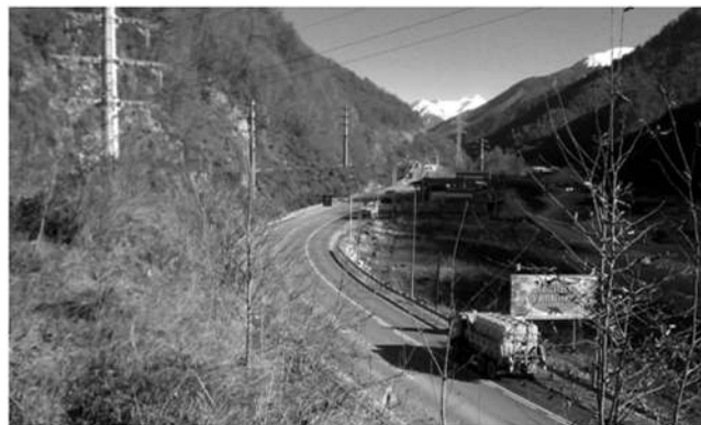
Рис. 12. Федеральная трасса Адлер-Красная Поляна, на которой установлены система СВК и стационарный пункт весового контроля
